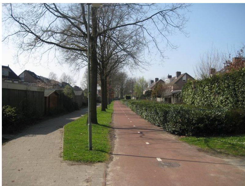
Vrijliggend fietspad door woongebied
