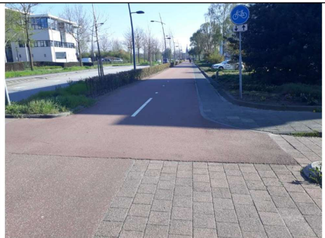
Fotonummer: 10: Bosscheweg in zuidelijke richting gezien ten zuiden van de rotonde
