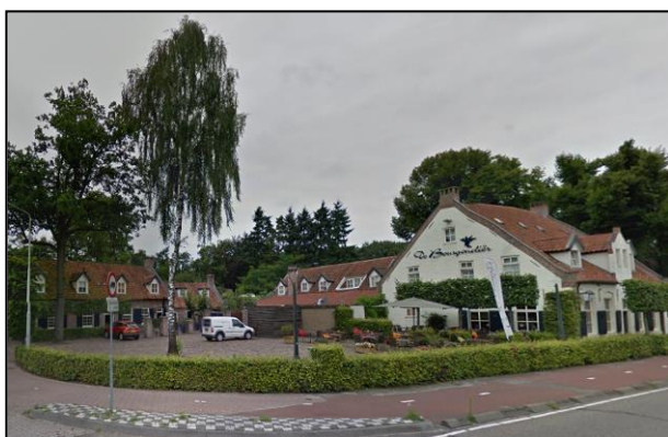
Aanzicht van de bebouwing in het plangebied. De panden aan de Bosscheweg en de Baandervrouwenlaan zijn nabij elkaar gelegen en vormen in ruimtelijk opzicht één geheel doordat het erf (verharding) van beide panden in elkaar overloopt.
