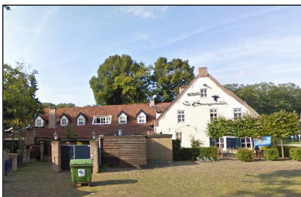
Aanzicht van het pand aan de Bosscheweg 133. Op de bouwlaag in kap wordt beoogd één bedrijfswoning te realiseren.
