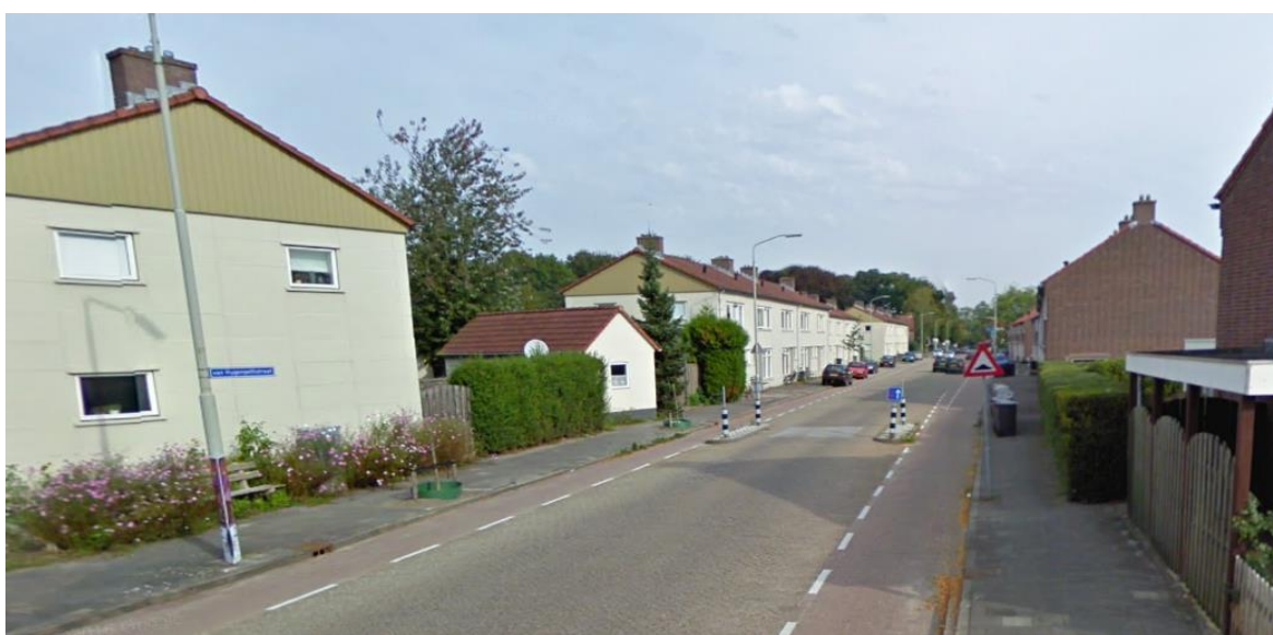
Figuur 3 Weergave van het plangebied ter plaatse van de Hendrika van Heaftenstraat en daaronder zicht op het plangebied ter plaatse van de Van Hugenpothstraat.
