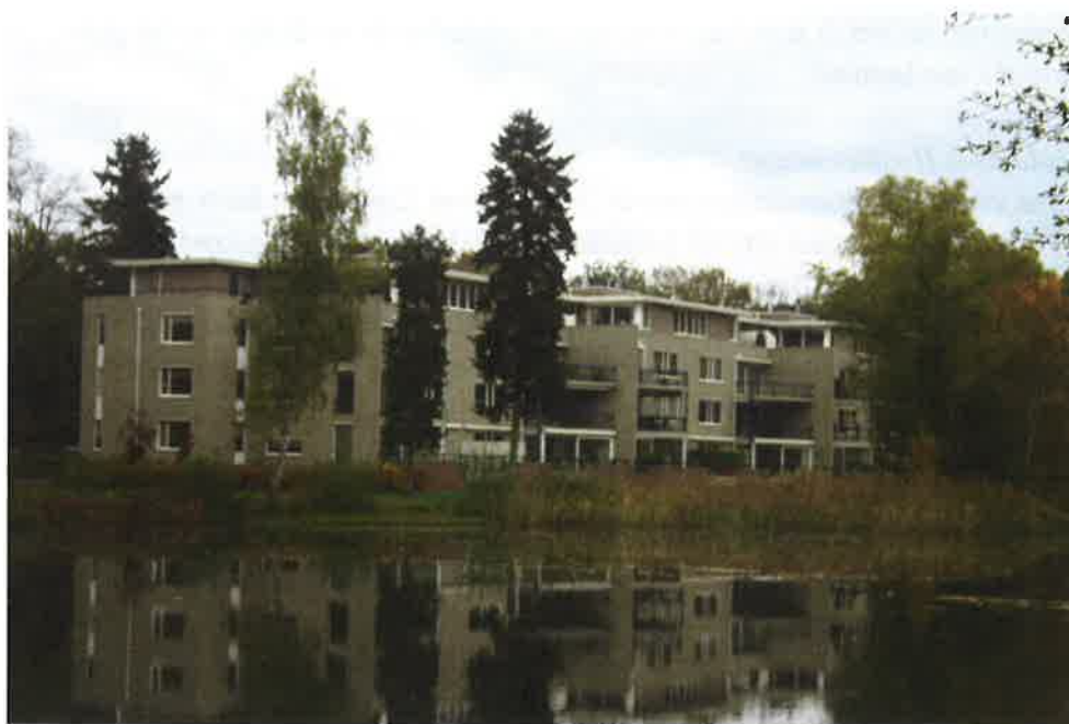
foto 4: Heerenven, met appartementencomplex op de achtergrond
