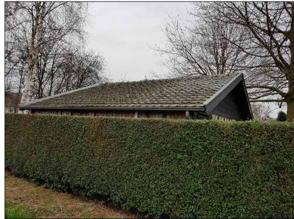
Figuur 5. Te verwijderen schuur in oosten plangebied
