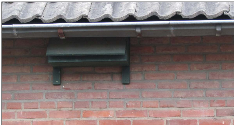
Figuur: aan het woonhuis hangen twee gierwaluwkasten.
