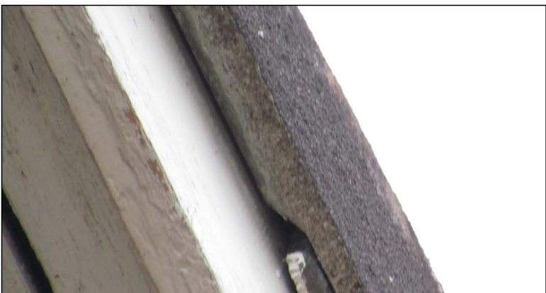
Figuur: vleermuizen kunnen door de kier onder de dakpannen komen en ze hebben mogelijk een verblijfplaats onder deze dakpannen.
