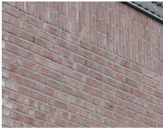
Figuur: Detail open stootvoegen (Kerkheiseweg 22a)
