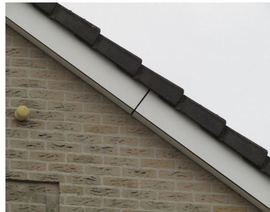
Figuur: Woning met ruimte onder kantpannen (Kerkheiseweg 23)
