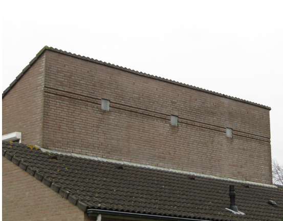
Figuur: Woning met open stootvoegen (Kerkheiseweg 21)
