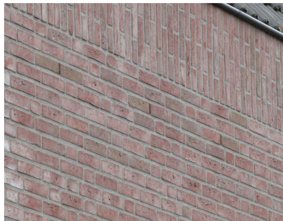
Figuur: Detail open stootvoegen (Kerkheiseweg 22a)
