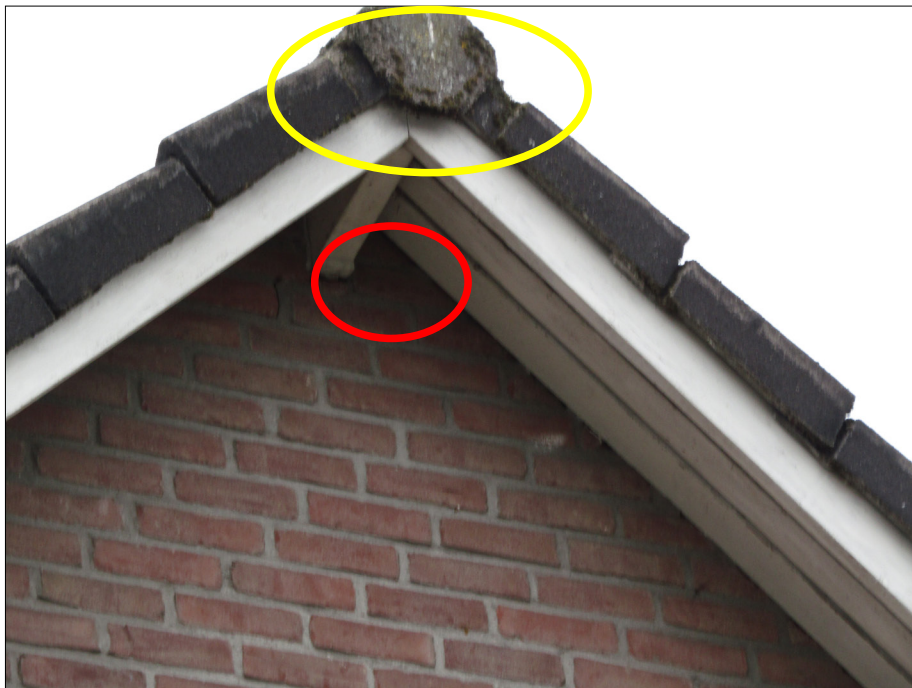
Figuren: Uitvliegopening met gele ovaal aangegeven. Het betreft de zomerverblijfplaats in de westgevel van de woning. Tegen de muur in de nok is ook een slaapplaats van boomkruiper waargenomen (rode ovaal).
