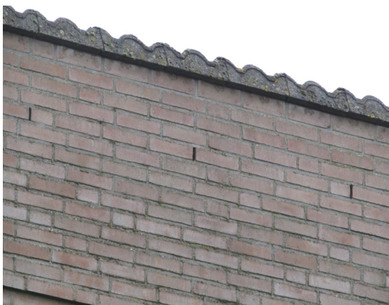
Figuur: Detail open stootvoegen (Kerkheiseweg 21)
