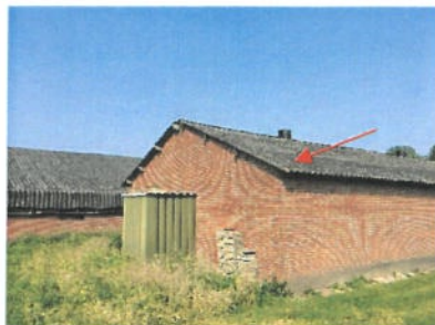
Aanzicht golfplaat, dak stal 4
