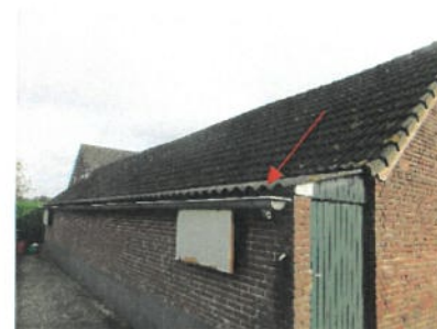
Aanzicht golfplaat, dak stal
