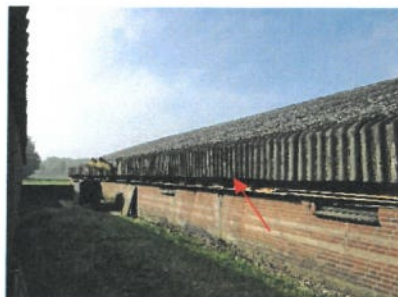
Aanzicht vormstukken, gevel stal 5
