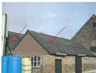
Aanzicht golfplaat, dak stal
