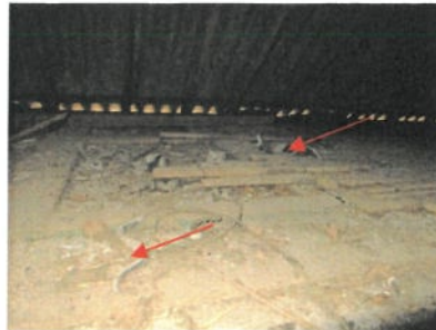
Aanzicht golfplaat, vloer zolder stal
