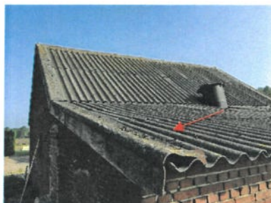
Aanzicht golfplaat, dak stal 2
