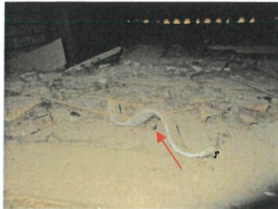
Aanzicht golfplaat, vloer zolder stal
