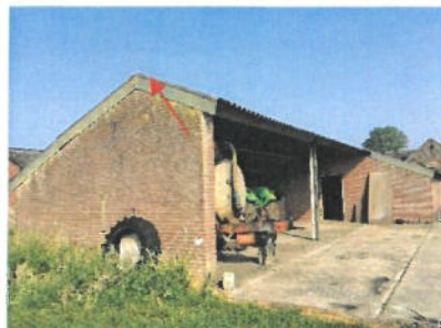
Aanzicht nok/windveer, dak aanbouw
