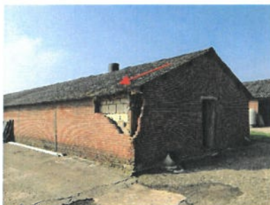
Aanzicht golfplaat, dak stal 3
