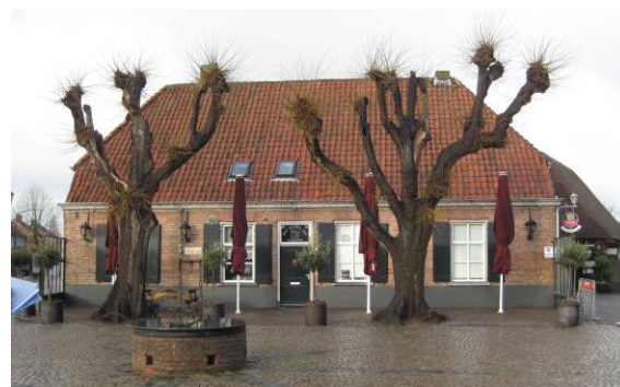
Langgevelboerderij aan Raadhuisplein (rijksmonument)
