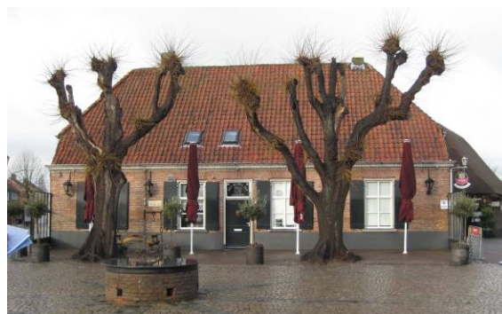
Langgevelboerderij aan Raadhuisplein (rijksmonument)
