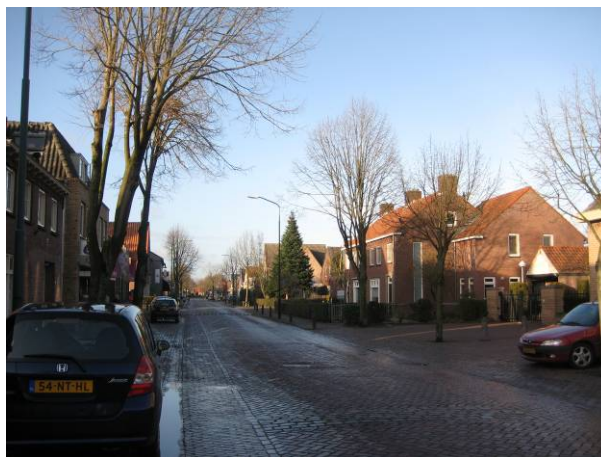
Eenvoudig straatprofiel met gebakken klinkers (Nieuwstraat)
