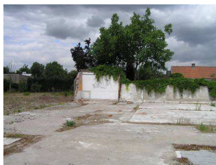
Noordzijde plangebied, met nog muurrestanten van de voormalige school.
