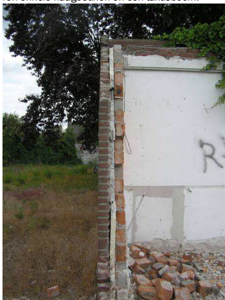
Restant van een muur met spouw, de spouw is gecontroleerd op mogelijke aanwezigheid van vleermuizen.
