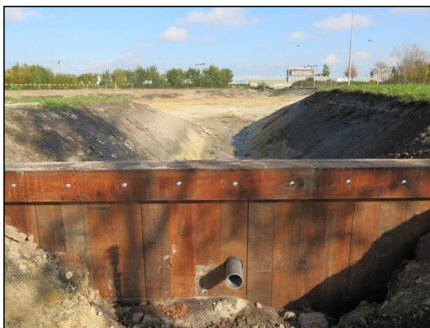
Figuur 7: Impressie damwandconstructie
