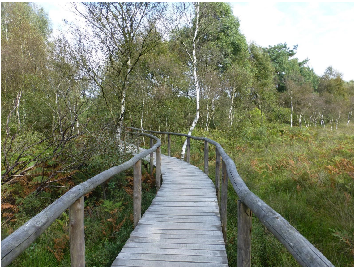
Vlonderpad met hekwerk. Hekwerk beschermd en begeleidt de wandelaars, houdt honden/kinderen echter niet tegen om natuur te verstoren
