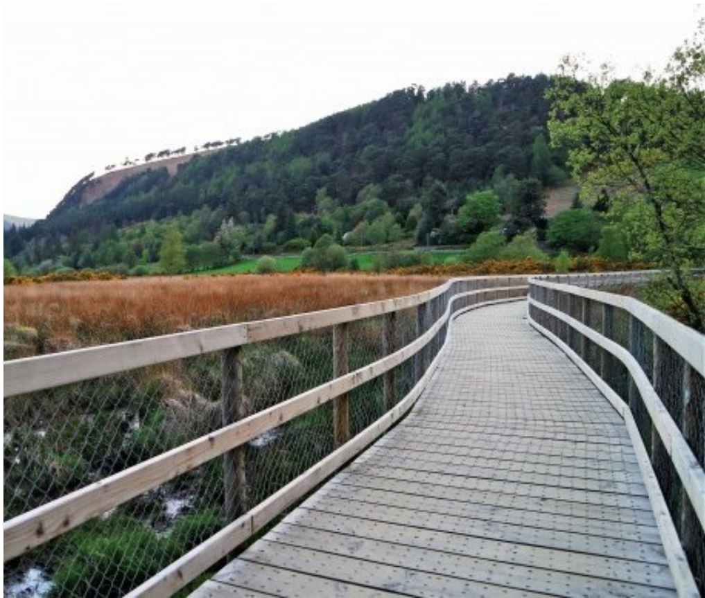
Vlonderpad met hekwerk. Hekwerk met gaas beschermd en begeleidt de wandelaars en weerhoudt honden/kinderen ervan om natuur te verstoren
