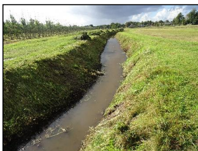
Figuur 7. De Heerenbeekloop, grenzend aan de zuidzijde van de onderzoekslocatie.
