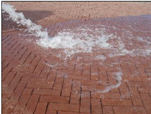
Figuur 11: waterpasseeerbare verharding (bron: www.aquaflow.nl )
