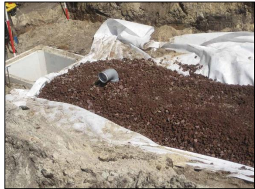
Figuur 12: lavakoffer (bron: www.hb-grondstoffen.nl )
