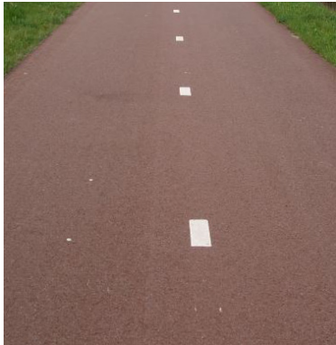
Fietspad Weikespad: rood asfalt
