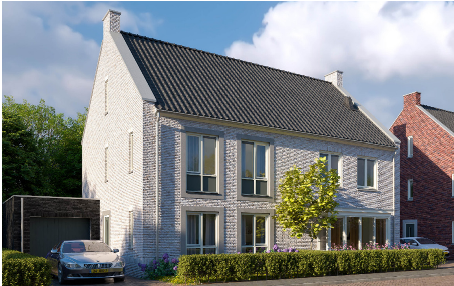
Hoge gevelopeningen met details rondom
