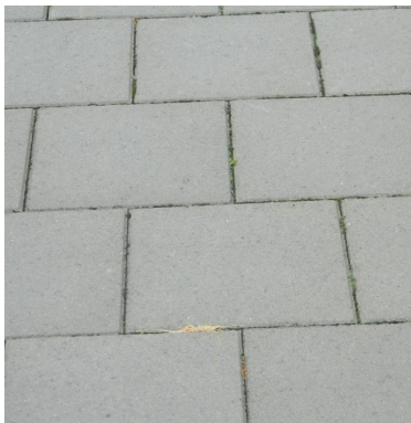
Trottoir: grijze betontegels
