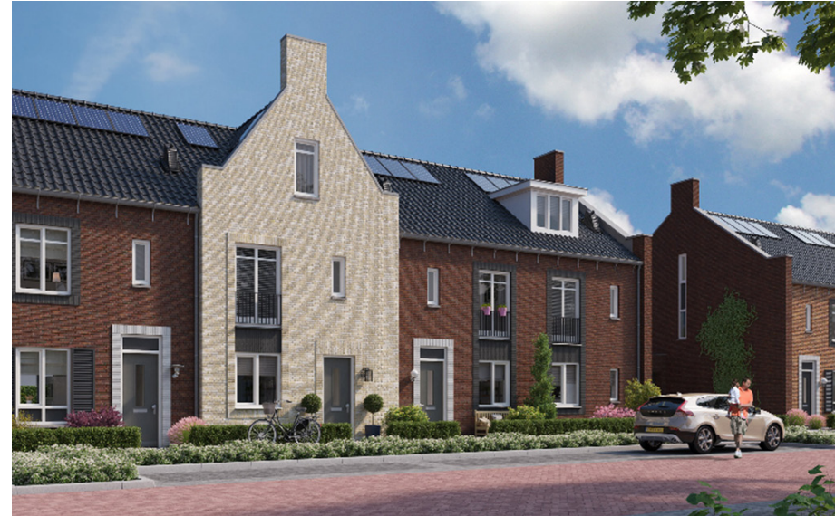
Doorgetrokken kopgevels met baksteendetails
