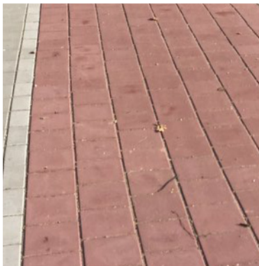
Fietspad: rode betontegels
