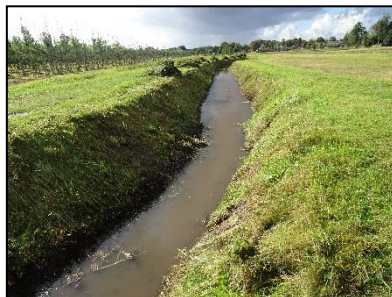
Figuur 7. De Heerenbeekloop, grenzend aan de zuidzijde van de onderzoekslocatie.
