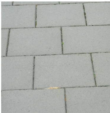
Trottoir: grijze betontegels
