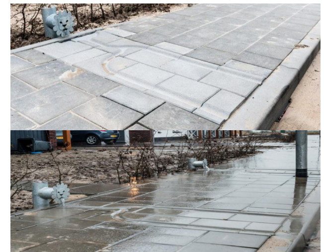
Voorbeelden van zichtbaar water afvoeren
