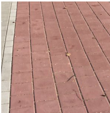
Fietspad: rode betontegels
