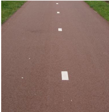
Fietspad Weikespad: rood asfalt
