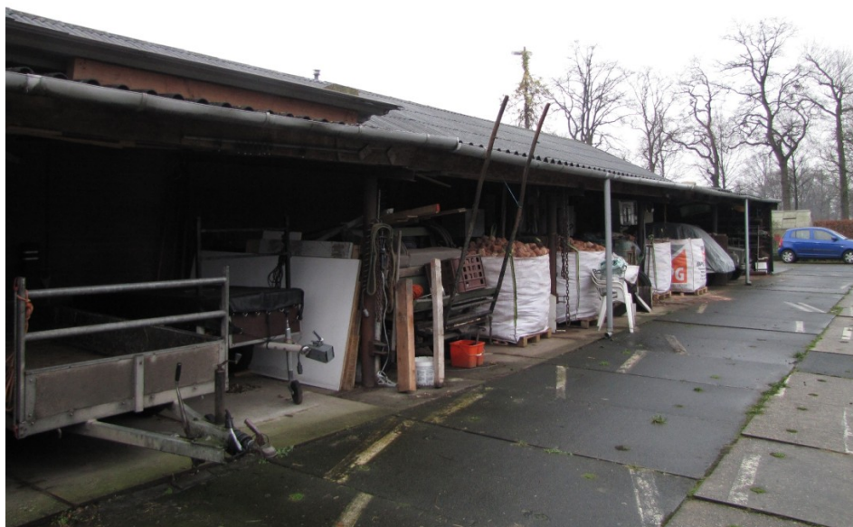
Figuur 3. Het te slopen deel van een van de beide overkappingen.
