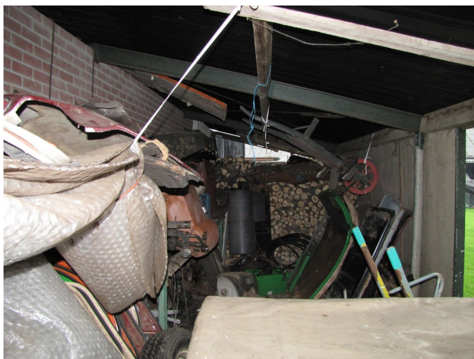
Figuur 5. Interieur van een van de te slopen overkappingen.
