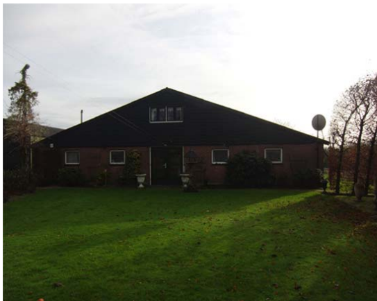
Figuur 4 Bestaande bebouwing
