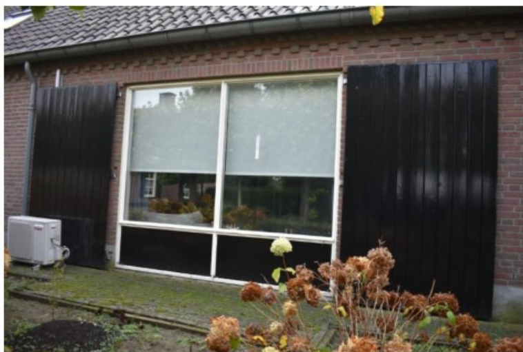
Samengesteld pui met 'staldeuren'.
