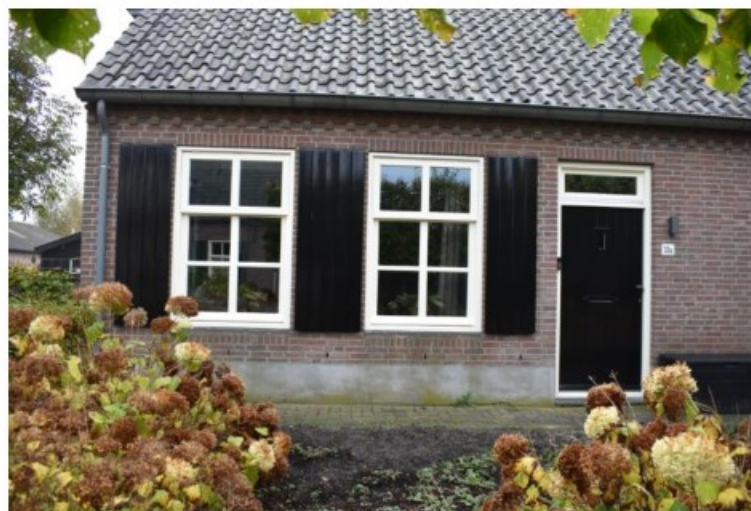
Woonkamervenster en entree.
