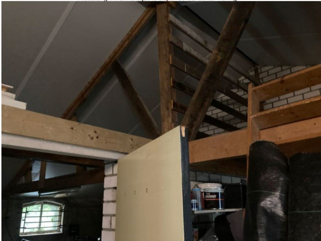
• Afbeelding 14: binnenzijde te slopen schuur achter woning
