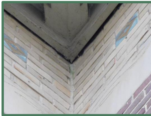
Ruimte tussen de houten betimmering en muren
