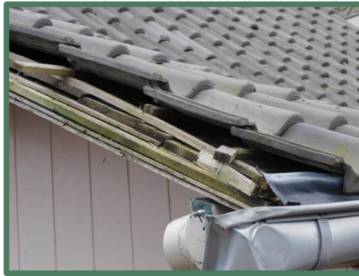
Gaten in de muren en ruimte tussen de dakpannen en het dak
