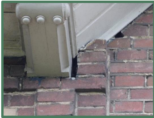
Gaten in de muren en ruimte tussen de dakpannen en het dak
