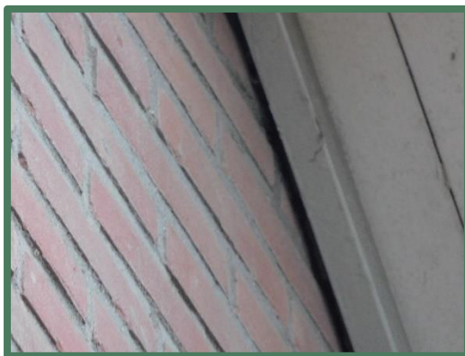
Ruimte tussen de houten betimmering en muren
