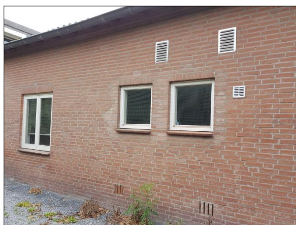
Figuur 6. Zijkant bedrijfspand
