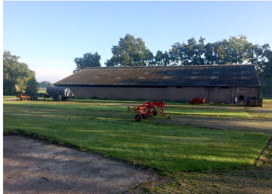
De bestaande schuur met de verharding (betonklinkers) aan de voorzijde
