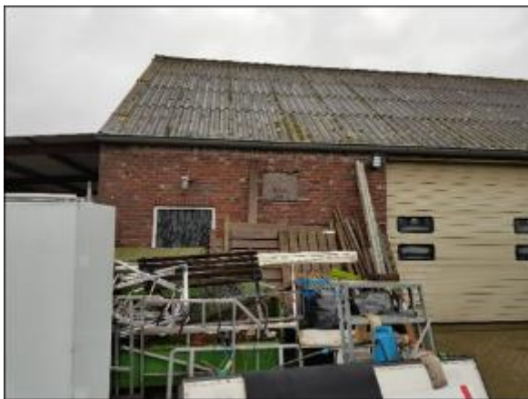
Figuur 2.1 Te slopen schuur
