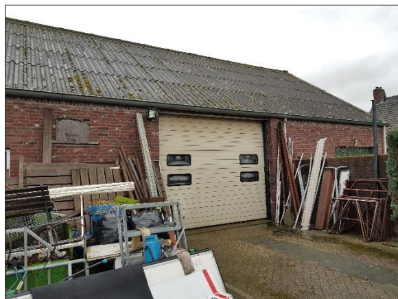
Figuur 7. Te slopen schuur gezien vanuit zuiden
