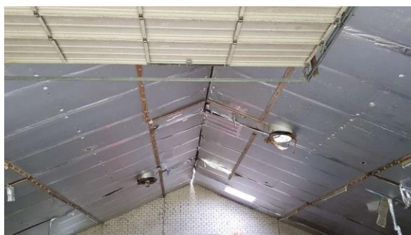
Stal 1, grotendeels Dupanel onder dak
