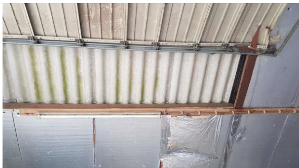
Stal 1, grotendeels Dupanel onder dak
