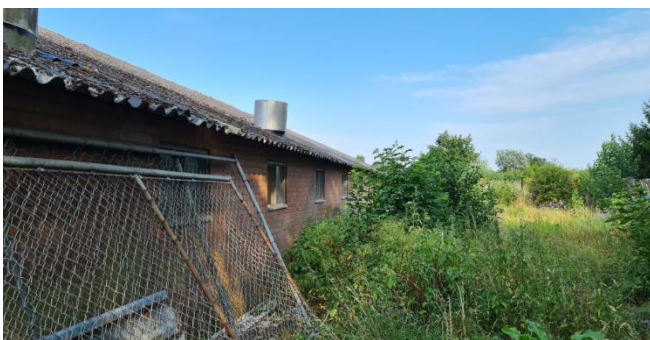
Figuur 4: Oostelijke stal en naastgelegen braakliggende terrein gezien vanuit het zuiden
