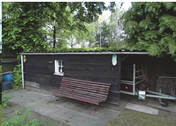
Figuur 4: Aanzicht te slopen houten schuurtje
