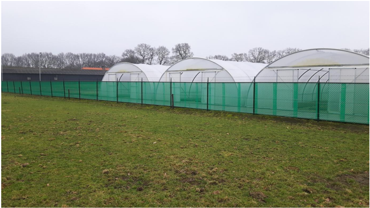
Figuur 2 Noordzijde van bedrijf, zicht op hekwerk en tunnelkassen.
