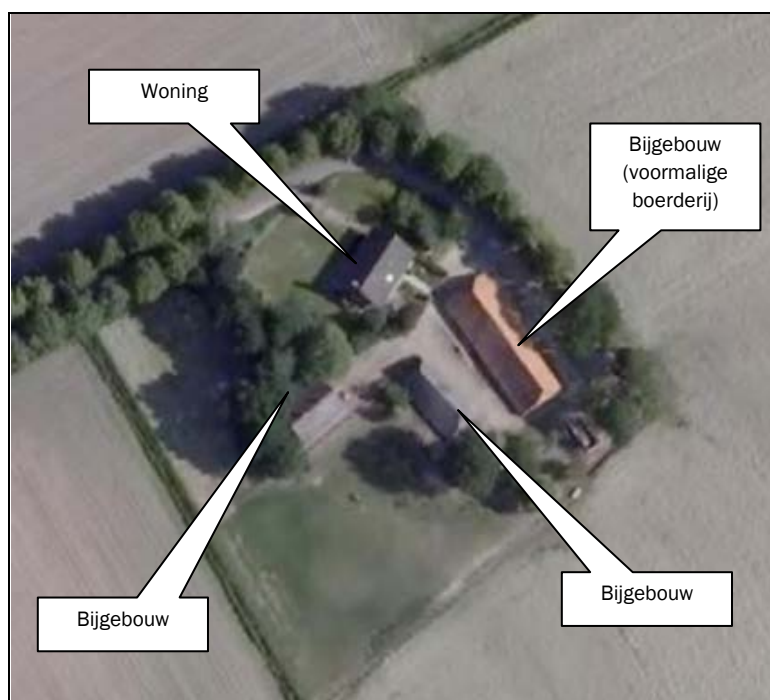
Figuur 4: Luchtfoto bestaande situatie
