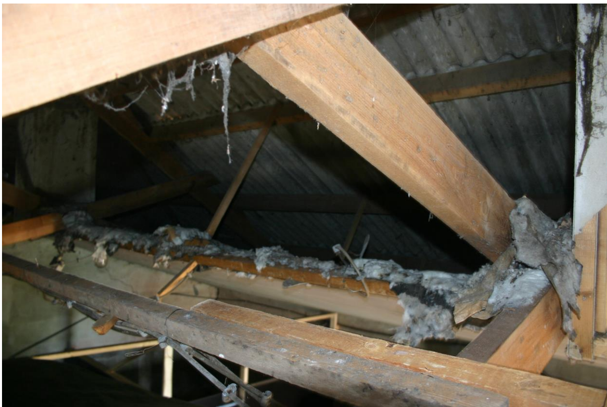
Figuur 8. De paardenstal was volledig te inspecteren.
