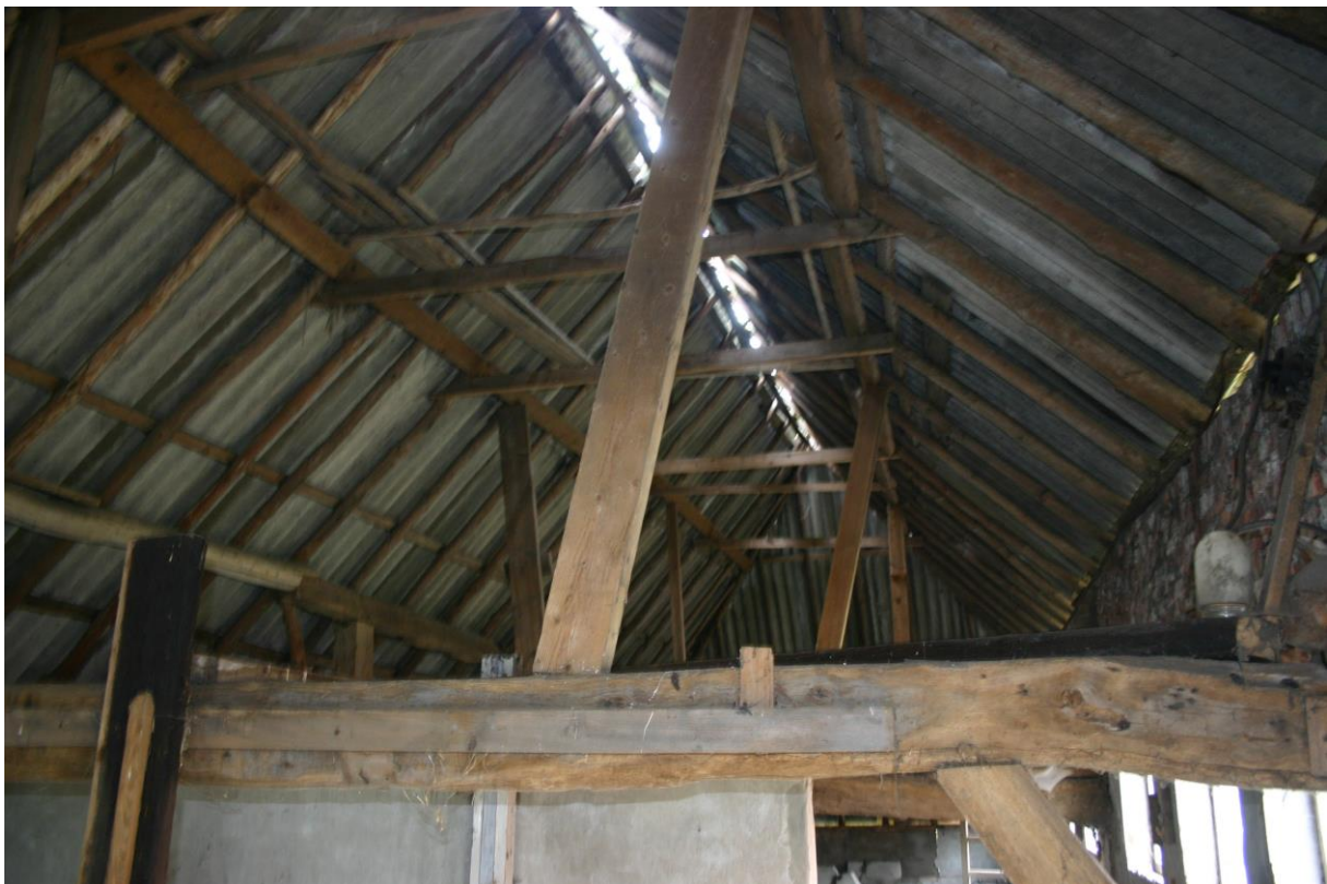
Figuur 7. Het dak en de wanden van de schuur zijn enkelwandig.
