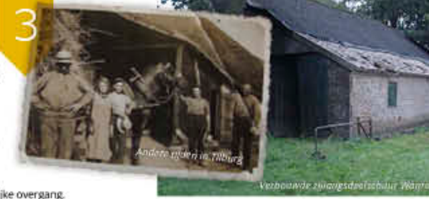
Verbouwde zijlangedeelschuur Wanroij
