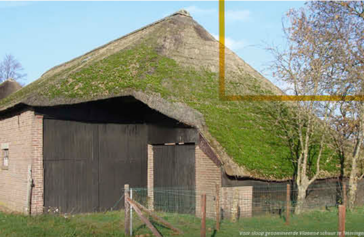
Voor sloop gereanimeerde Vlaamse schuur in Zeteringen
