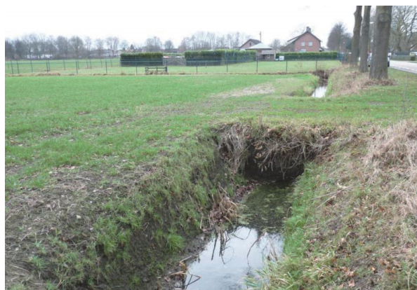
Fig. 4. Waterhoudende sloot tussen plangebied en berm, met dam en duiker op de voorgrond. Foto genomen in westelijke richting
