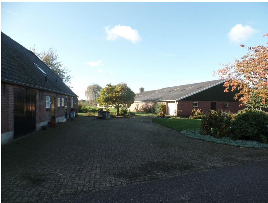
Fig.3. Zicht op het plangebied vanaf de openbare weg.
