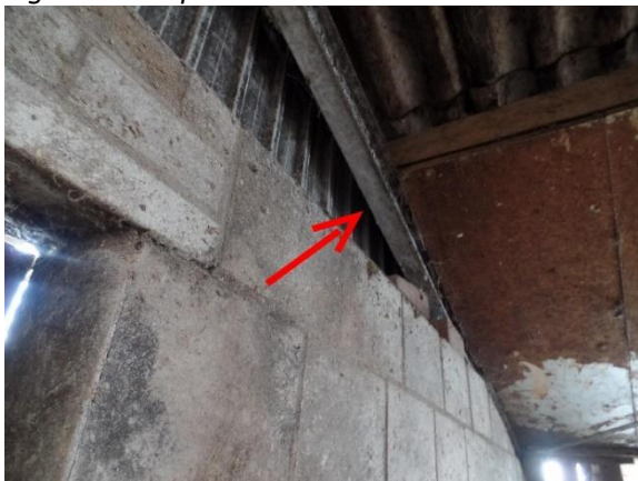
Fig.20. Pijl wijst in richting van de toegangsplek achter de isolatie[platen]
