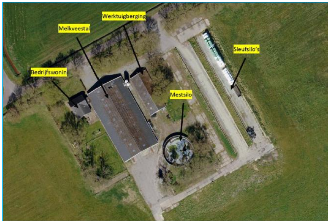
Figuur 9 – weergave bestaande bebouwing
