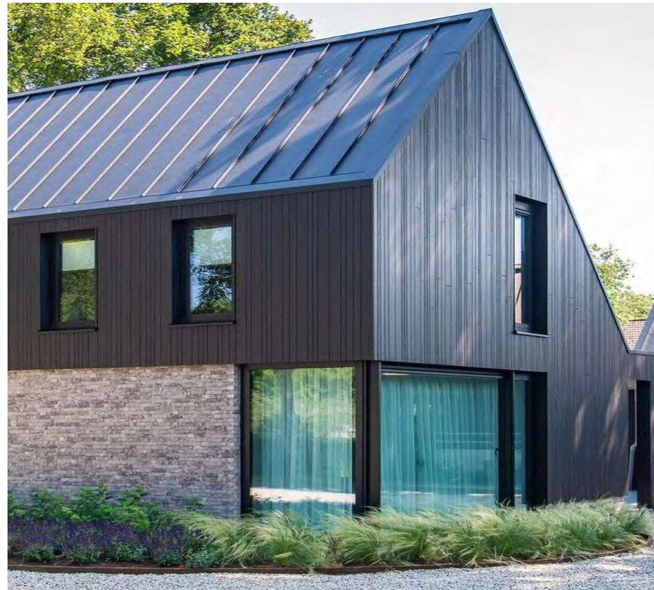
metselwerk als plint
