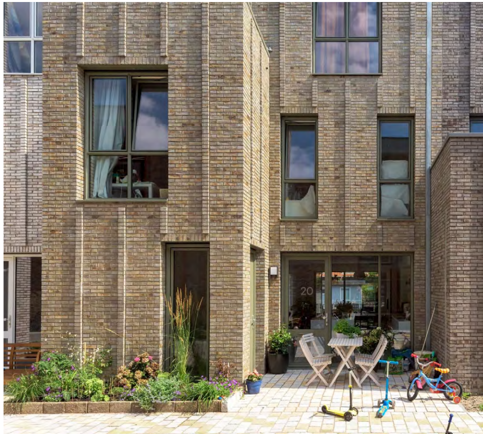
verticale plastic door uitmetselen
