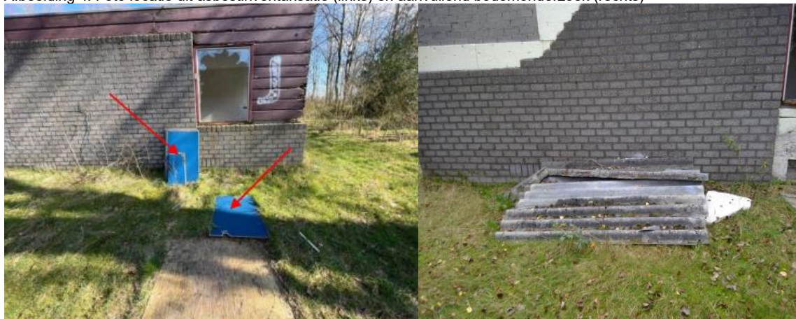
Afbeelding 4: Foto locatie uit asbestinventarisatie (links) en aanvullend bodemonderzoek (rechts)
