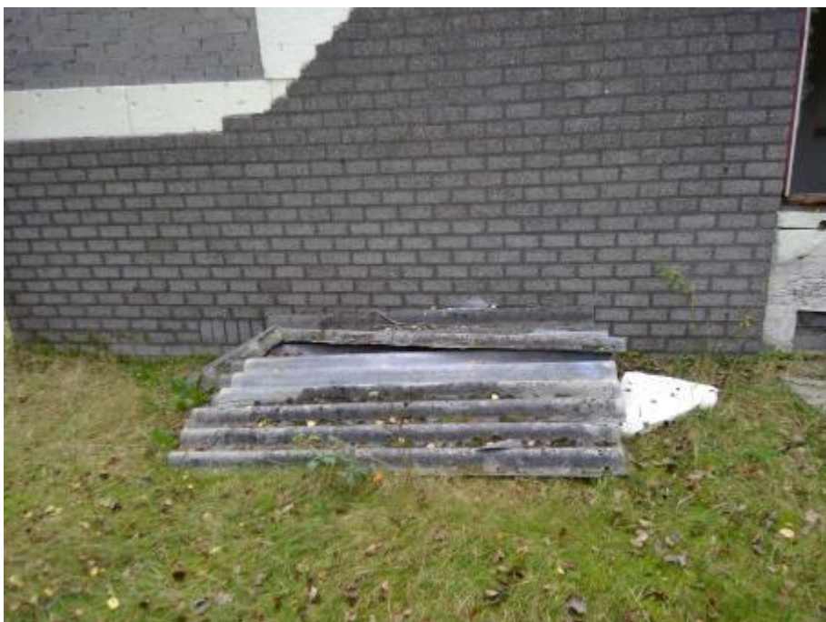
Foto 1: Op locatie aangetroffen golflaten
