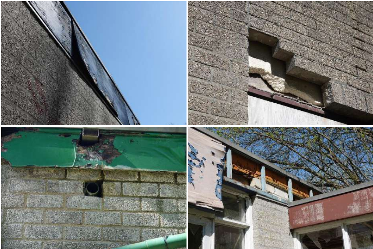
Figuur 13 Mogelijkheden voor vleermuizen of via openingen een route de bebouwing in te vinden en hier een verblijfplaats aan te leggen. Foto's: Bureau Biota.
