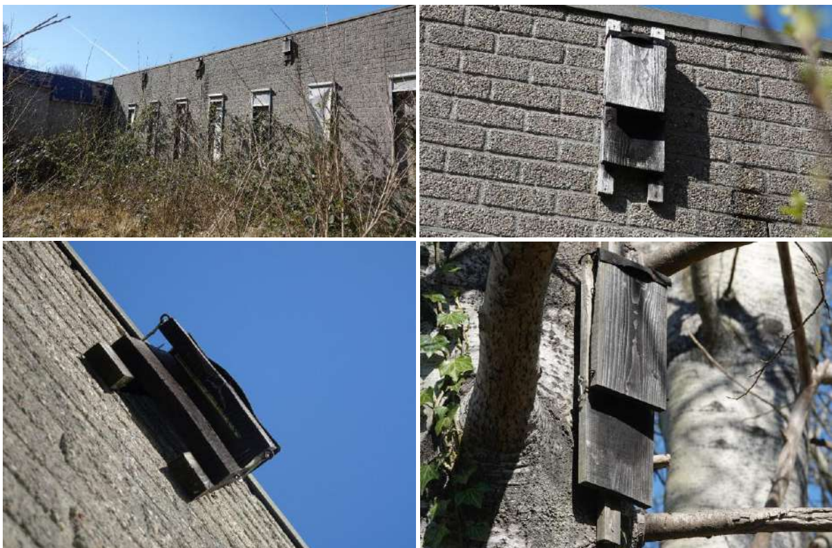
Figuur 14 Vleermuiskasten aan het gebouw en de bomen in het plangebied. Hoewel veel van deze kasten in slechte staat verkeren is het voor sommige nog wel mogelijk om als verblijf voor vleermuizen te fungeren. Foto's: Bureau Biota.
