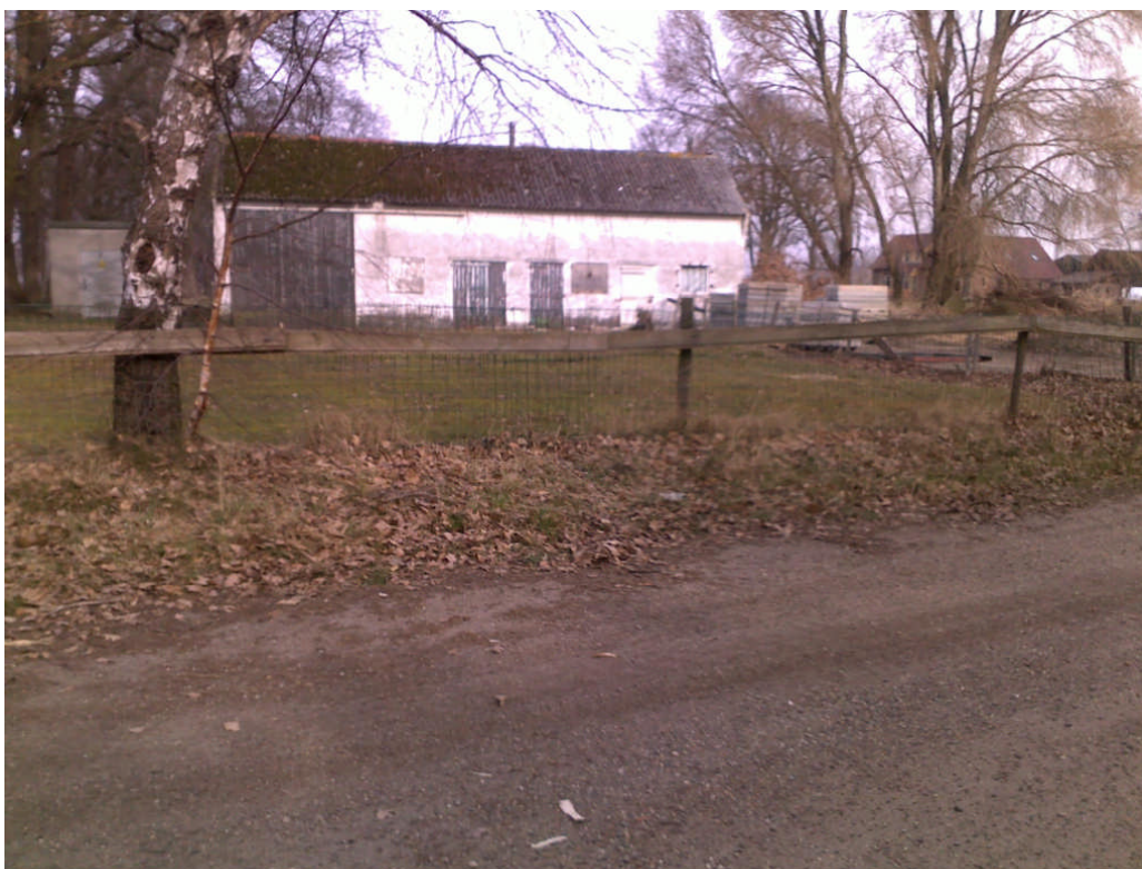
Directbouw, foto bij ingang van de bedrijfslocatie (verharding asfalt/asfaltpuin)
