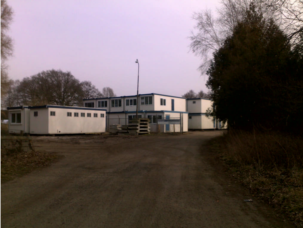
Directbouw, foto bij ingang van de bedrijfslocatie (verharding asfalt/asfaltpuin)
