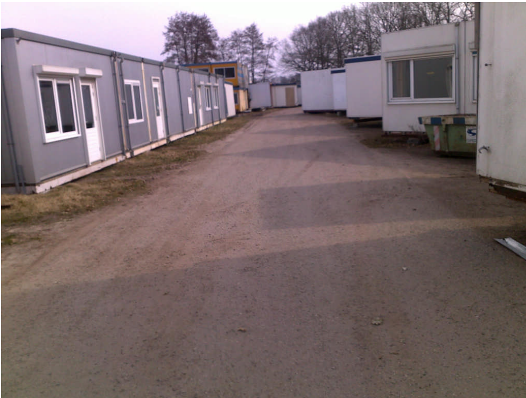
Foto Directbouw, asfaltverharding
