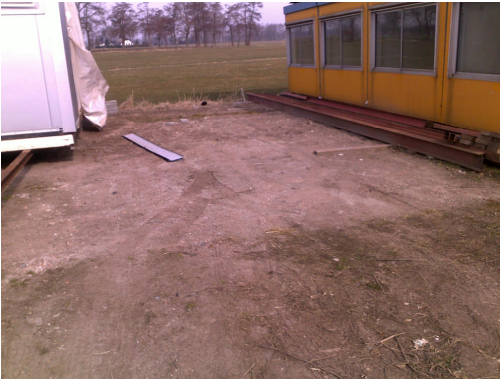
Foto Directbouw, puin verharding, hoogteverschil met naastliggend landbouwperceel
