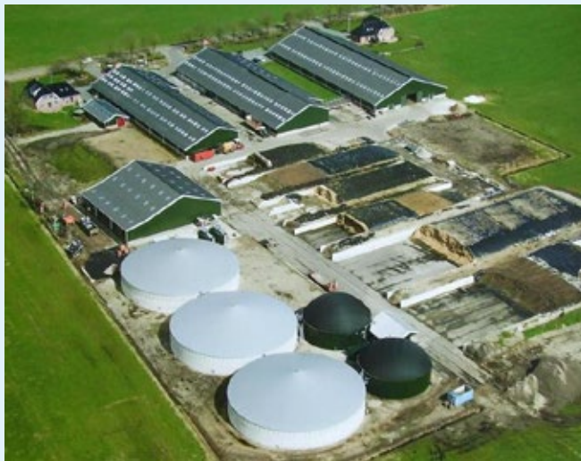
Vergistingsinstallatie op boerderijschaal; www.hoSt.nl
