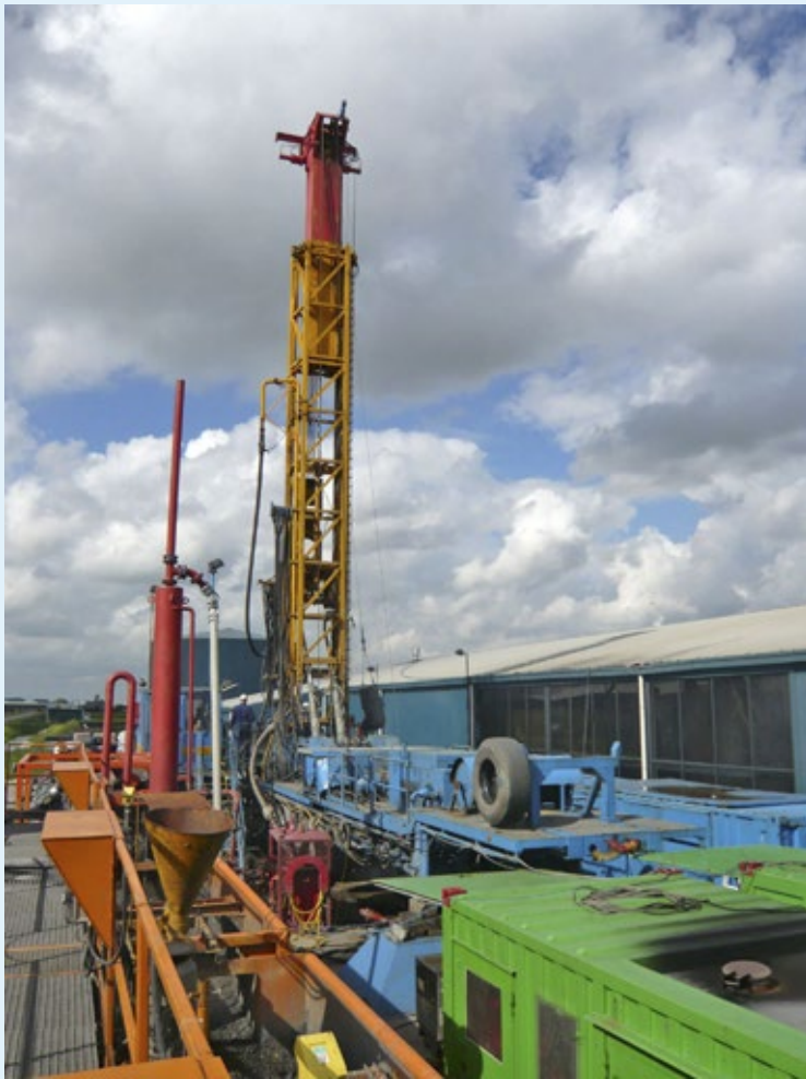
Geothermieboring in Bleiswijk (Bron: http://www.geothermie.nl/index.php?id=23; ).
