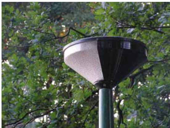
Figuur 7. Voorbeeld van een aangepast armatuur: afgeschermd naar boven en naar achteren (bron: Herman Limpens, Zoogdiervereniging).
