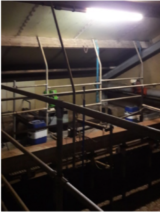
Figuur 2.3 Zicht op in pandige aerobe en anaerobe tank Bedrijf 2.
