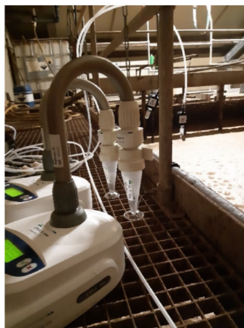
Foto's B3.4 en B3.5 Bedrijf 2 meetopstelling op beluchtingstank met twee Coriolis apparaten en filterkoppen zichtbaar.
