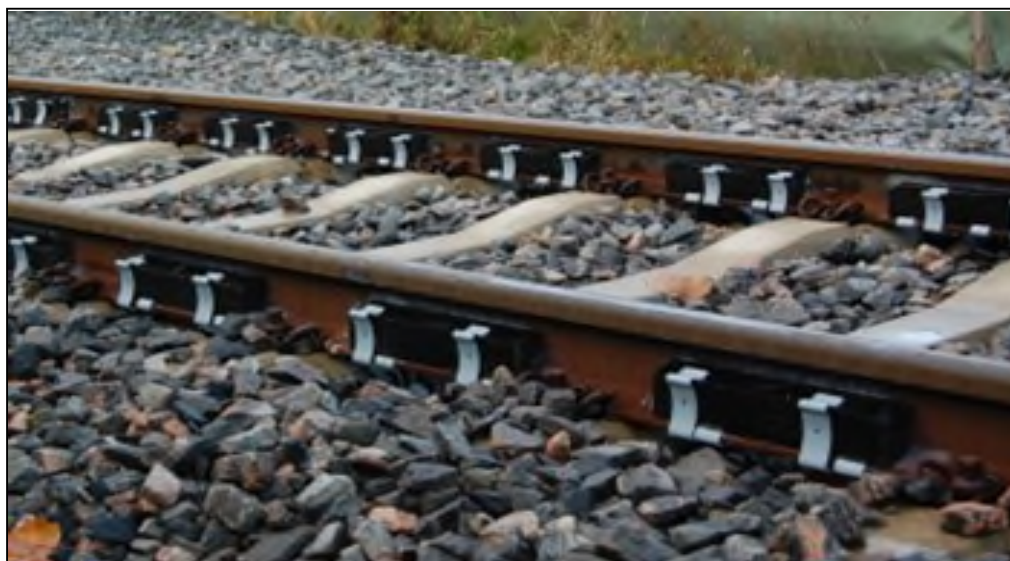
Figuur B1-2 Voorbeeld van de bronmaatregel raildempers.
