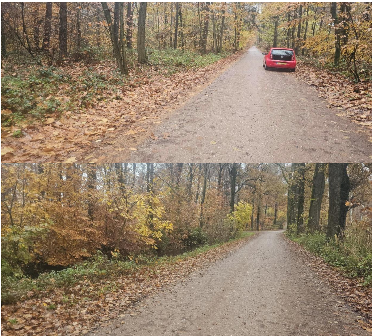
Figuur 1.16: Impressie van de werkweg (Locatie 9) aan de Koningsweg, Wehl.
