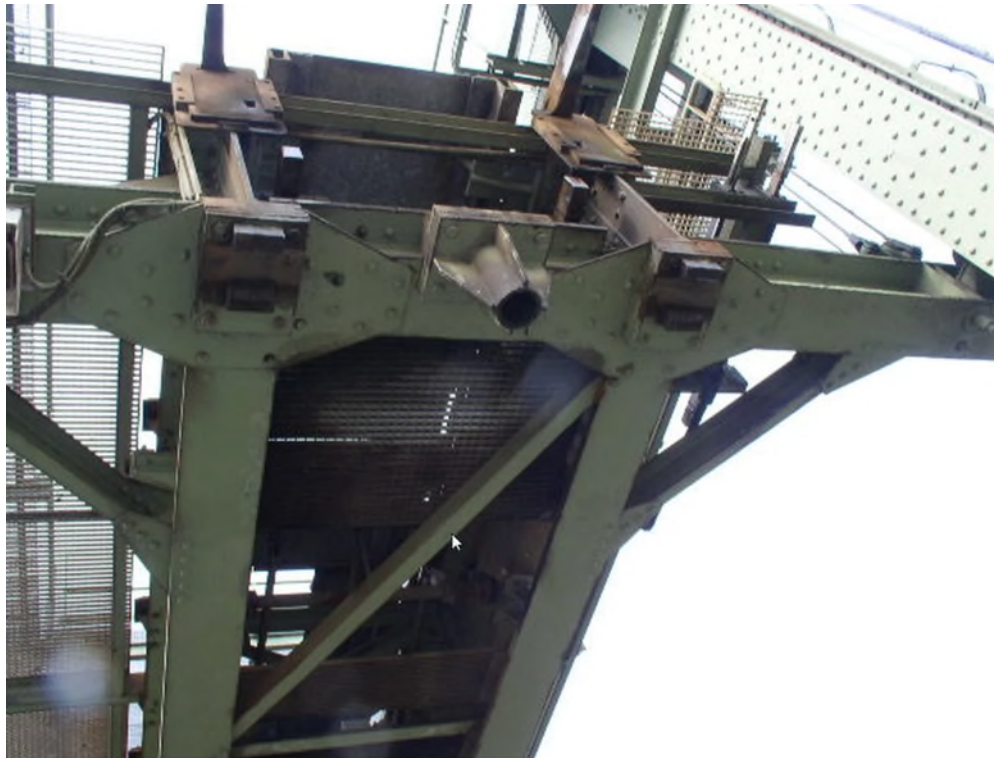
Figuur 11 Aanzicht onderzijde hefbrug
