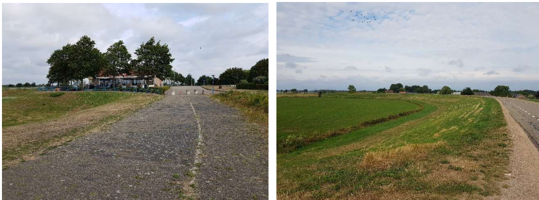
Figuur 2-10 Verhoging van het eethuisje en de dijk met kenmerkende knik
