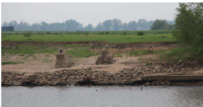
Figuur 5-7 Impressie verzakte verdediging westelijke oever veerhaven
