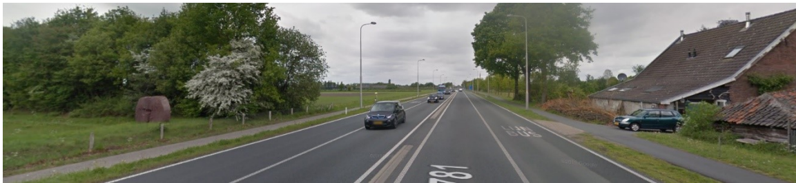
Afbeelding 2.9 Huidige profiel ter plaatse van de Lumentuin, ten noorden van de rotonde en rijdend richting het noorden
